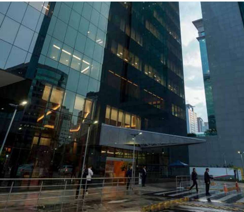
Nova sede do Bradesco, em São Paulo, concentra áreas de Atacado do Banco
